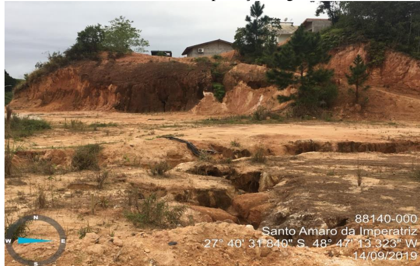
Figura 34 – Encosta situada na Servidão Domingos F. dos Santos, bairro Varginha, com evidências de processos erosivos lineares e de rupturas em solo derivado de rochas do Complexo Águas Mornas, diante da intervenção antrópica para retirada de material de empréstimo em solo e retaludamento para implantação de condomínio de casas, resultando em verticalização dos taludes aliado a ausência de proteção vegetal
