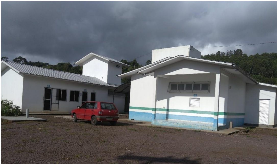
Figura 14 – Unidade de Beneficiamento de Peixes. Anchieta/SC.
