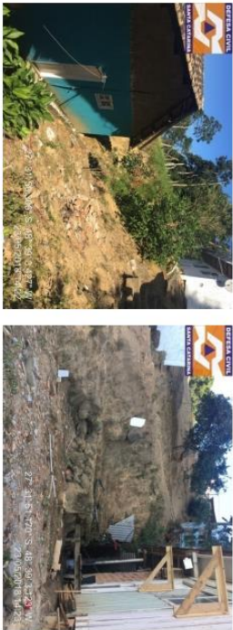
Foto 13: Observar a proximidade das moradias com os respectivos taludes de corte, que estão em solo exposto e não possuem nenhuma medida estrutural contra deslizamentos.
