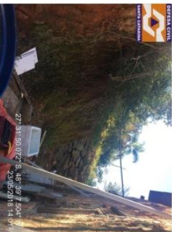
Foto 5: Moradia situada próximo ao talude de corte verticalizado e sem proteção contra deslizamentos e/ou processos erosivos.
