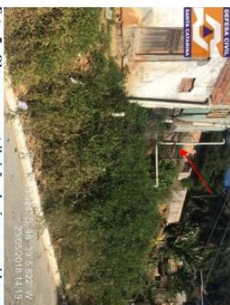
Foto 7: Observa-se contribuição de águas servidas no talude de corte, aumentando o risco de deslizamentos.
