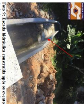
Foto 9: Escada hidráulica construída após os eventos de deslizamentos e enxurradas na área de inspeção.
