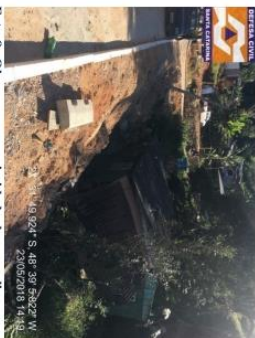
Foto 8: Observar a proximidade da moradia com o talude de corte, sedando risco. Futuros deslizamentos ou erosões podem ainda causar danos à pista de rolagem, comprometendo seu bom funcionamento e locomoção.
