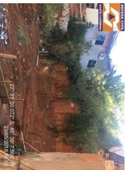
Foto 4: Talude de corte verticalizado com solo exposto e vegetação em sua crista.
