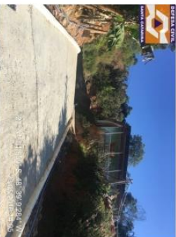
Foto 6: Rua pavimentada para evitar a retirada de material da sua base e poder estar acessível mesmo em eventos pluviométricos intensos.
