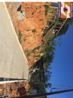
Foto 2: Vista geral da rua onde estão situadas diversas moradas ao longo do talude de corte e aberto, com risco de deslizamento e enxurradas.
