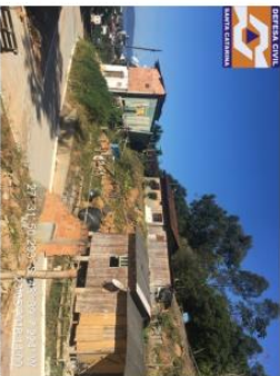
Foto 1: Casas situadas em talude de corte verticalizado, apresentando alta vulnerabilidade e risco de deslizamento e enxurradas
