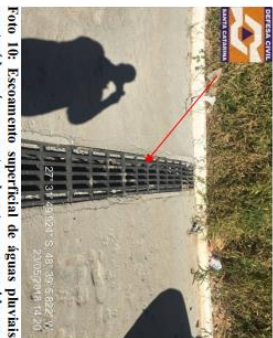
Foto 10: Escamento superficial de águas pluviais, construído após os eventos desastrosos ocorridos em anos anteriores.
