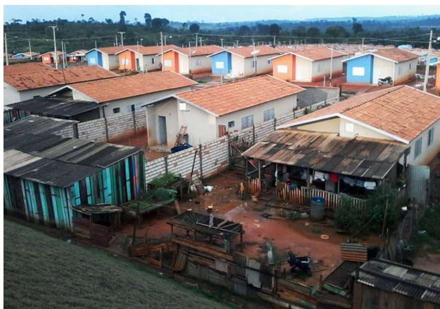
Figura 22: Casas no RUC de alvenaria com pedaços de madeira
