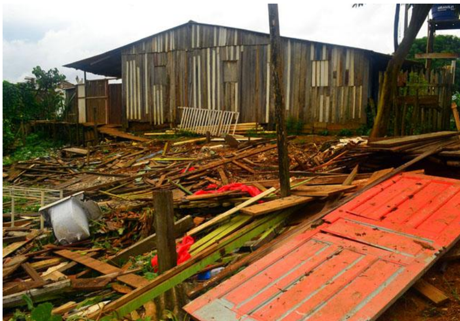
Figura 21: Casa de palafita sendo derrubada no processo de desapropriação
