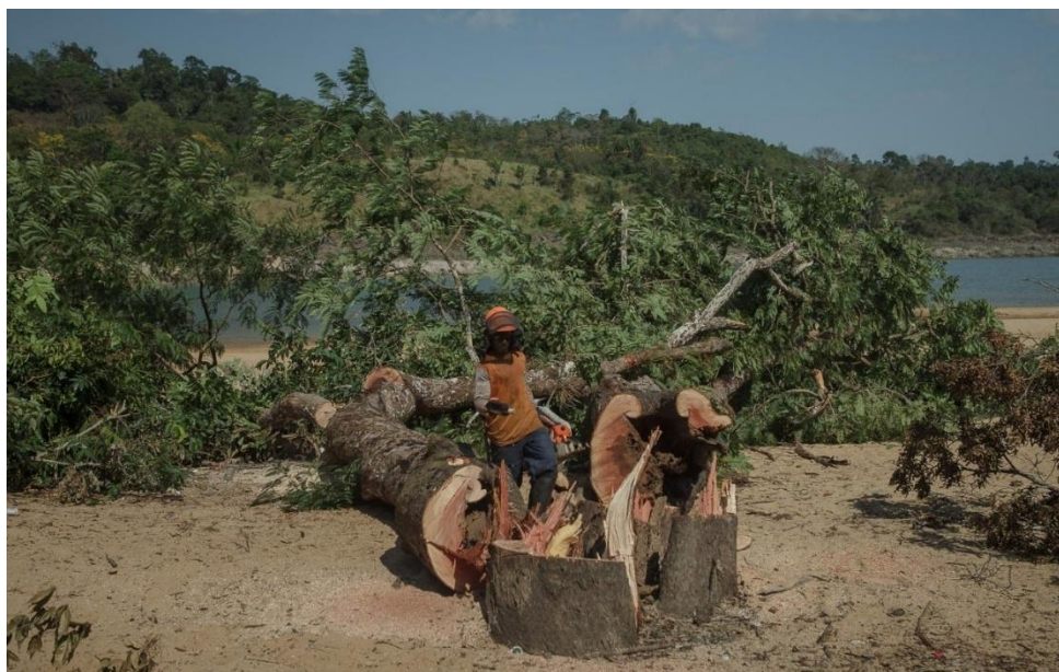
Figura 9: Trabalhador corta árvores para dar lugar ao lago da usina de Belo Monte
