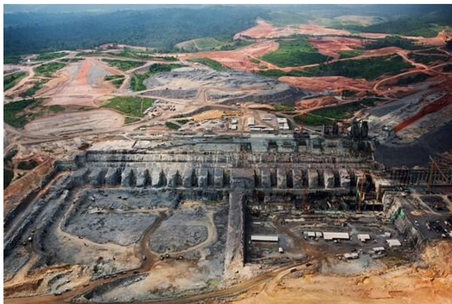
Figura 7: Início da construção da Hidrelétrica de Belo Monte no Rio Xingu
