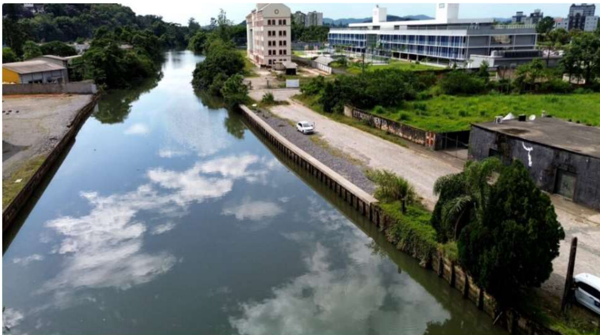
Figura 54 – Local que se dará início ao Parque Linear Porto Cachoeira
