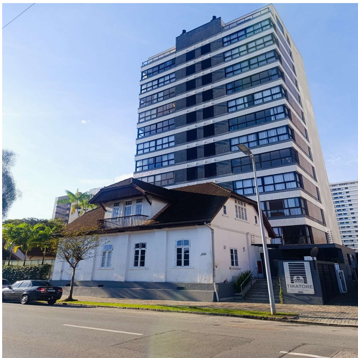
Figura 61 – Imóvel tombado na Rua Duque de Caxias, nº 160
