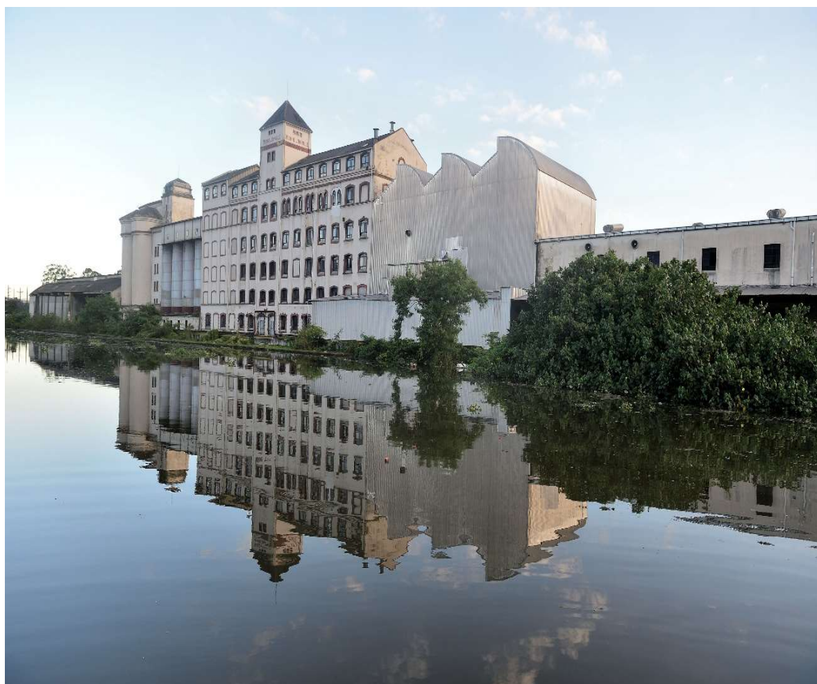
Figura 51 – Prédio do Moinho Joinville em 2023
