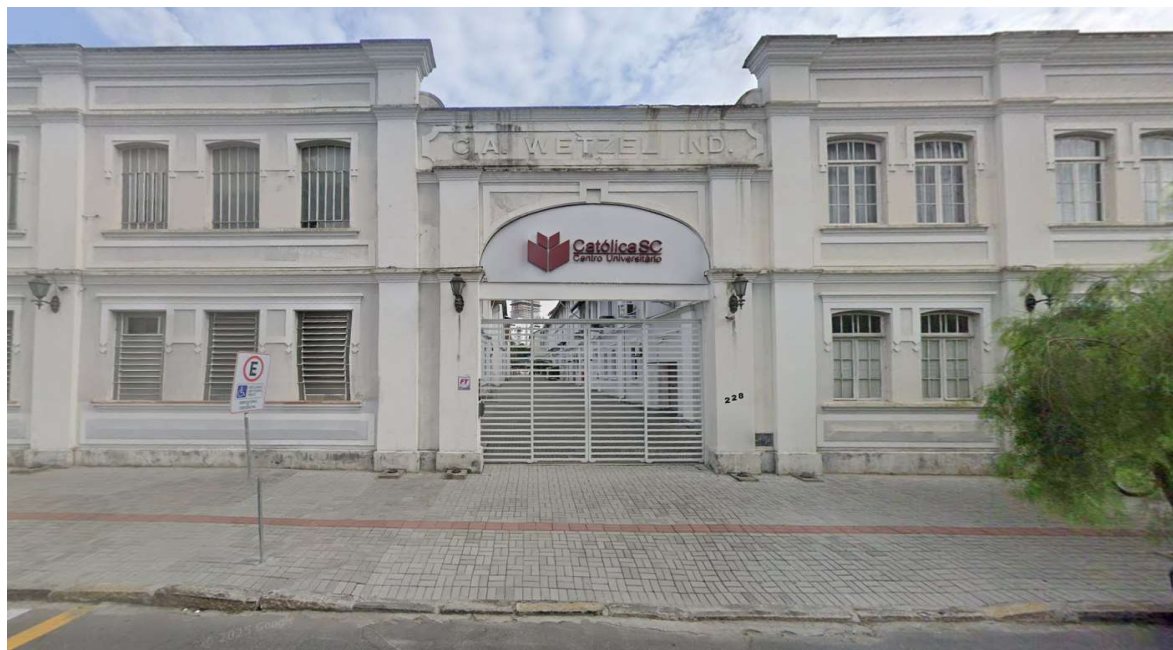
Figura 48 – Fachada da Pontifícia Universidade Católica de Santa Catarina (PUC/SC), vista da Rua Senador Felipe Schmidt
