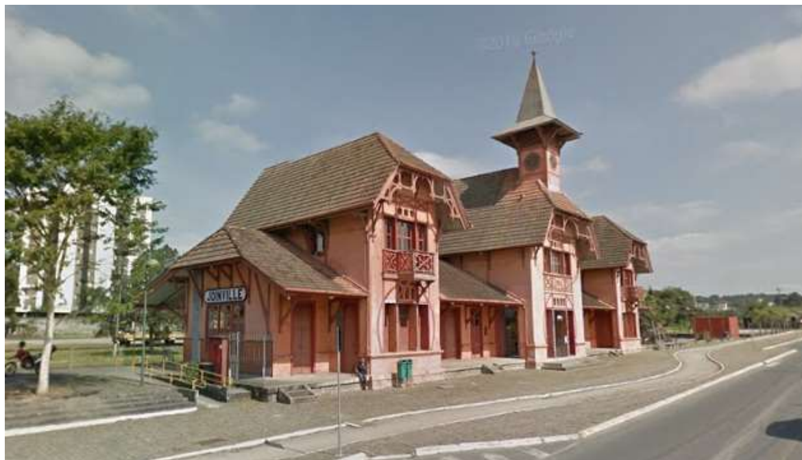
Figura 21 – Estação da Memória de Joinville
