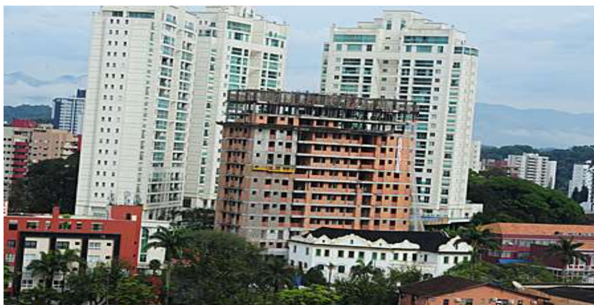
Figura 59 – Pallazzo Anthurium em construção
