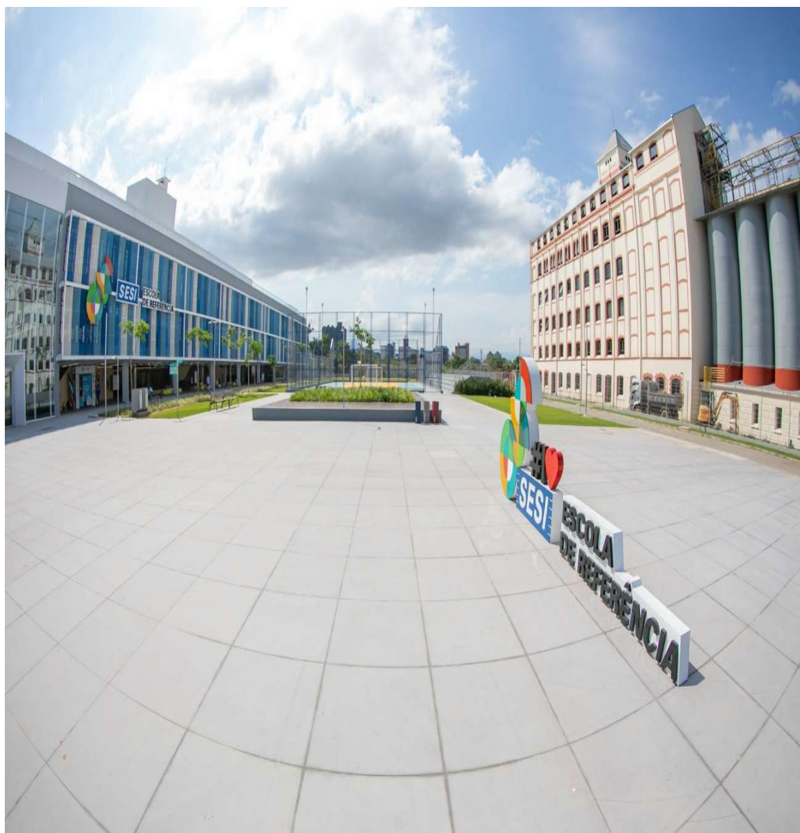
Figura 52 – Prédio da Escola Sesi
