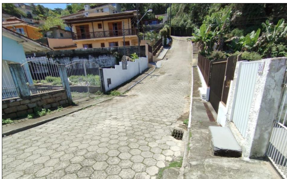
Figura 36 - Fundo de vale sujeito a fluxo torrencial na servidão Firmino Linhares
