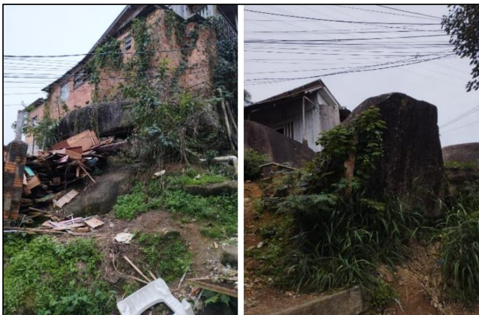
Figura 29 - Afloramento de blocos rochosos na servidão Pedra de Listra (Morro do Caju)
