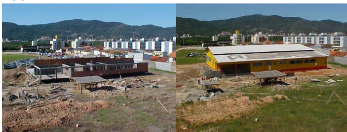
Figuras 3 e 4 – Construção do primeiro prédio do CEBM, em 2004
