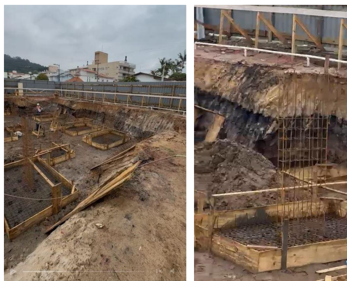
Figura 2. Construção sobre Espodossolo em Canasvieiras
