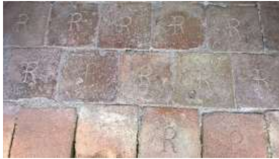
Figura 14 – Soleira da porta externa de acesso ao pátio interno
