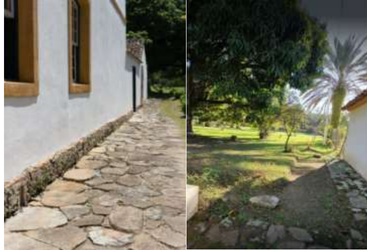
Figura 12 – Caminhos em pedra (lateral e fundos do sobrado)
