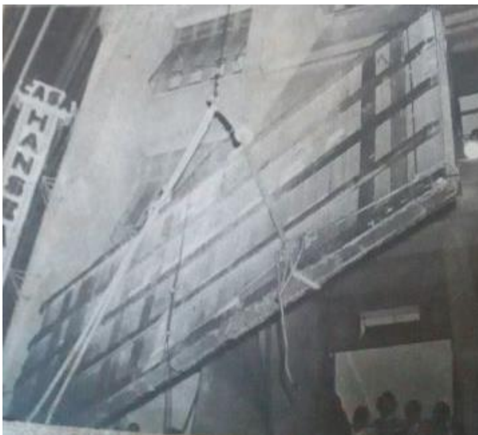
Figura 10 – Chegada do isolamento acústico em vidro e aço – içagem ao auditório
