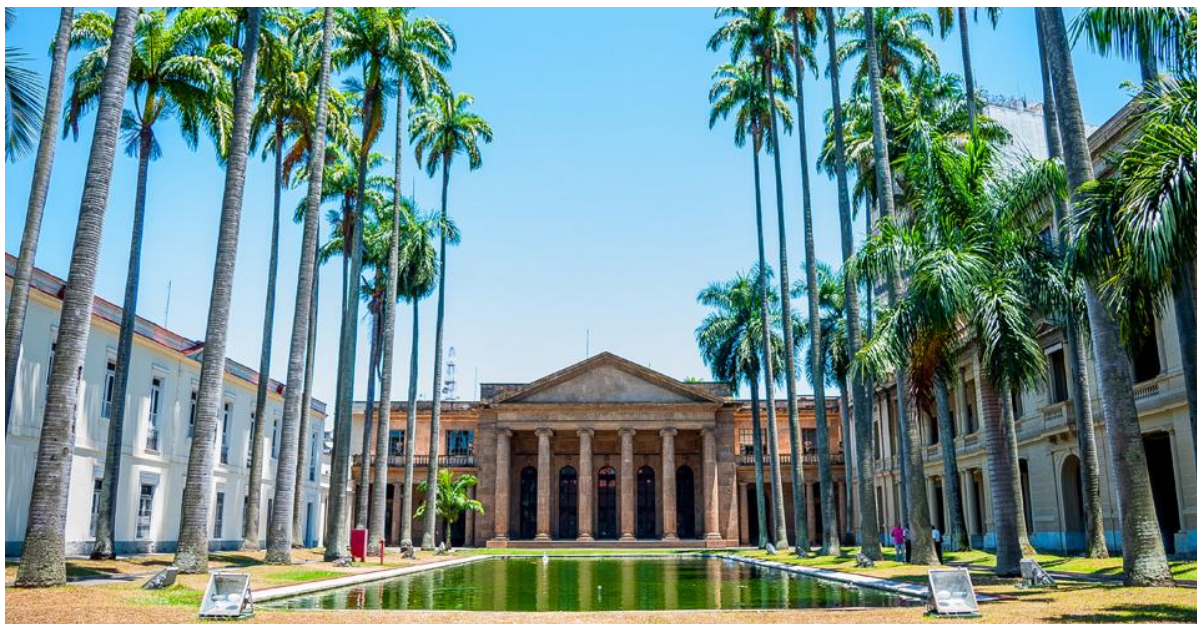
Figura 17 - Palácio do Itamaraty nos dias de hoje. Foi construído entre 1851 e 1855 e sede do MRE entre 1899 a 1970
