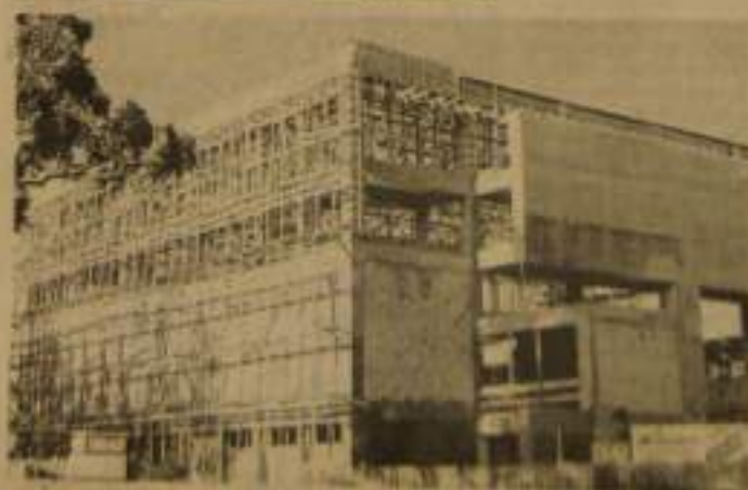
PALÁCIO - Obras do Centro de Cultura e Extensão devem ficar prontas até o que vem
