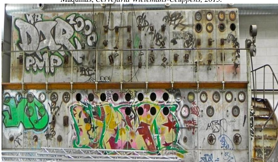
Figura 48: Central de controles de energia, transformador e indicador graduado de tensões e potências. Casa de Máquinas, Cervejaria Wielemans-Ceuppens , 2013.
