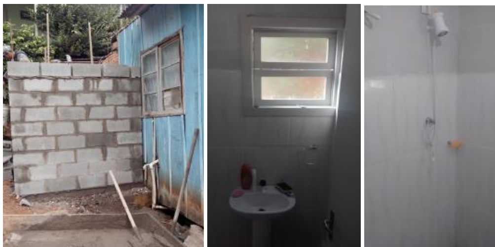
Figura 8 – Etapas da construção de um módulo Hidráulico
