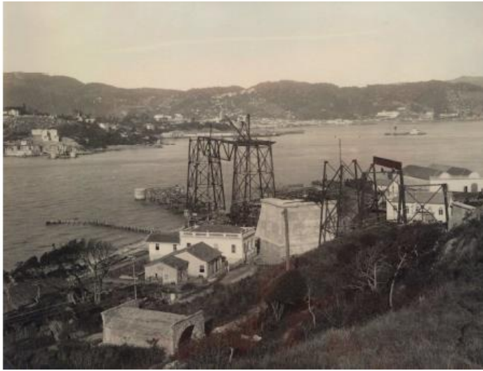
Figura 4 -Início da construção da Ponte Independência (1922 – 1926).
