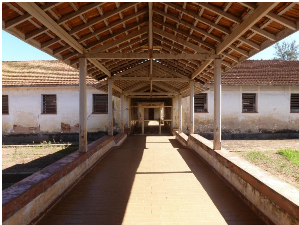
Figura 15 - Imagem de vistoria de estudo de tombamento: corredor que unifica fileira de pavilhões de tratamento do antigo Asilo Colônia Cocais
