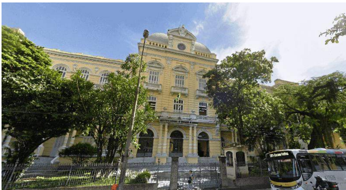
Figura 1 – Prédio do INES e que está na região Laranjeiras, localizado Rio de Janeiro
