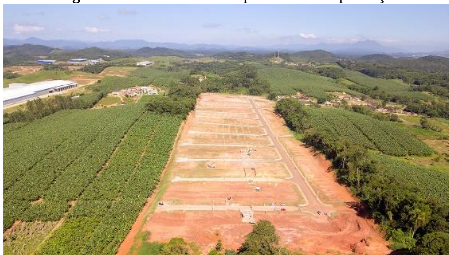
Figura 17 – Loteamento em processo de implantação
