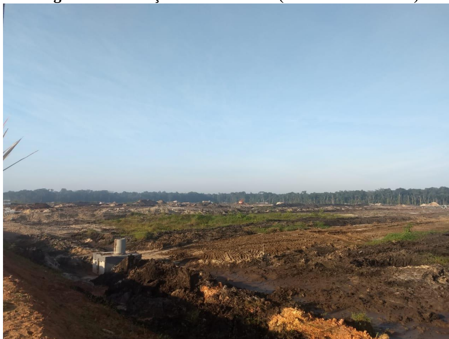
Figura 1 – Execução de Loteamento (Bairro Porto Grande)
