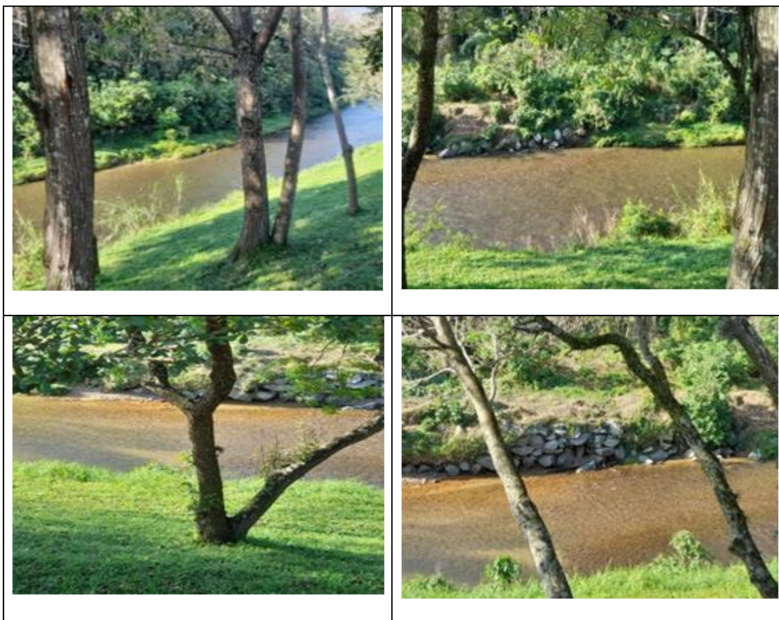
Figura 8 - Margens do rio Cubatão do Sul com o enrocamento
