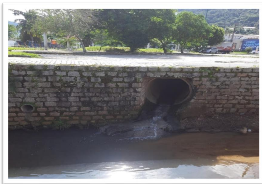
Figura 40. Ocorrência de disposição de esgoto na rede Pluvial
