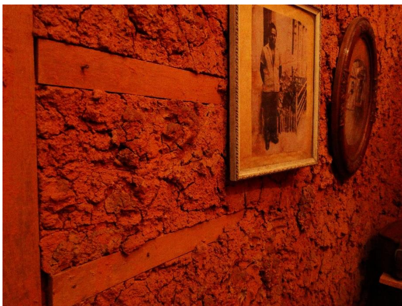
Figura 28 – Museu da Maré: Parede com reprodução de técnica de construção de pau a pique
