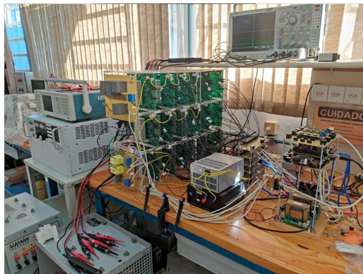
Figura 2. Protótipo do Conversor Modular Multinível a Capacitor Chaveado, implementado no nPEE
