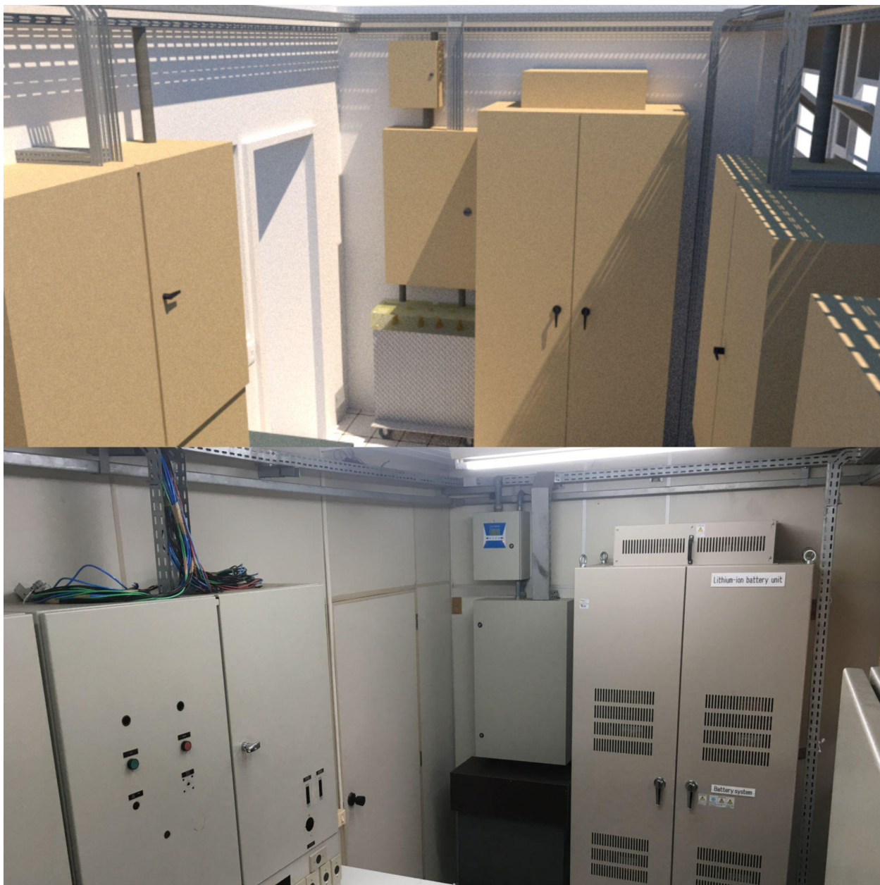
Figura 2. Adequação da estrutura da sala para a instalação da nanorrede.
