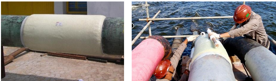
Figura 1. Trechos de tubulações metálicas reparados com material compósito (Fonte: www.rust.com.br )
