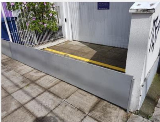
Figura 2. Exemplos nacionais de dispositivos para mitigação dos riscos de inundações em residências
