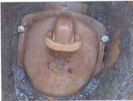
Válvulas que serão instaladas e não permitem o retorno da água
