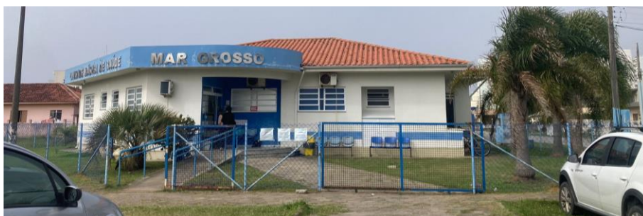
Figura 1. Fachada da UBS Mar Grosso, nota-se as características citadas como, acessos irregulares e com vegetação, sem vagas de estacionamento sinalizadas e área de manobra fora da circulação de pedestres. Falta de sinalização e comunicação com o entorno.
