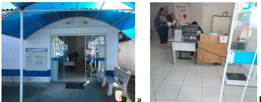
Figura 1. À esquerda, foto da entrada principal com placa de identificação apenas visual e de difícil leitura à distância. À direita, balcão de atendimento que obstrui a visualização da atendente sem a presença de sinalização tátil ou painel informativo. Fonte: Acervo pessoal das autoras, 2023.
