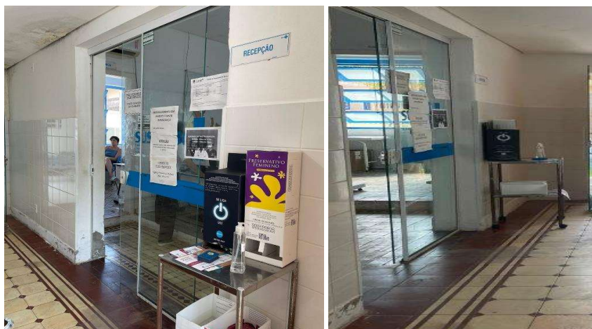
Figura 1. Acesso a recepção da UBS, nas imagens pode-se observar que o acesso à recepção se dá através de uma porta de correr em vidro que não possibilita uma abertura adequada para a passagem de mais de uma pessoa. Também é possível notar que o corredor interno não possui largura adequada para aproximação ao balcão de atendimento, não possui espaço para circulação quando há atividade e nem largura adequada para deslocamento e giro de 180° por P.C.R.
