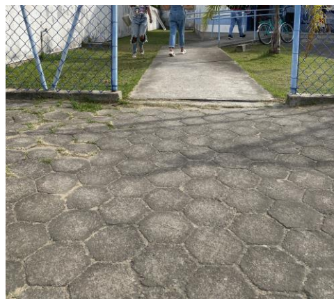
Figura 2. (a) Calçada da UBS Magalhães, em partes deteriorada e sem sinalização tátil no piso, com desnível na faixa de circulação de pedestres. (b) Calçada da UBS Esperança em material trepidante e sem sinalização tátil no piso. Fonte: Acervo pessoal da autora, 2023.
