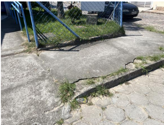
Figura 2. (a) Calçada da UBS Magalhães, em partes deteriorada e sem sinalização tátil no piso, com desnível na faixa de circulação de pedestres. (b) Calçada da UBS Esperança em material trepidante e sem sinalização tátil no piso. Fonte: Acervo pessoal da autora, 2023.
