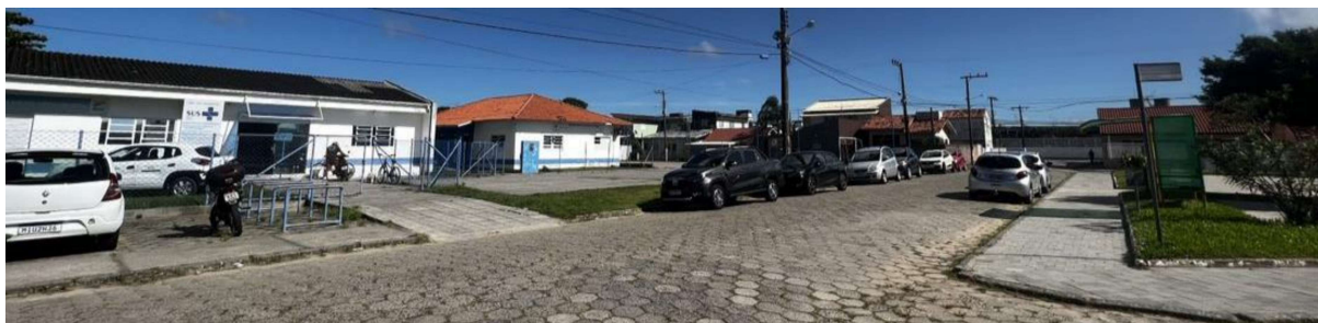
Figura 1. Acesso principal com calçada de um lado, porém com área de estacionamento e manobra sobre a circulação de pedestres, e do outro, ausência de calçada e gramado.
