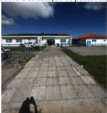
Figura 2. Rampa de acesso com piso trepidante e deteriorado, à esquerda e trilho do portão, à direita, o qual apresenta desnível e dificulta o deslocamento de pessoas em cadeira de rodas.
