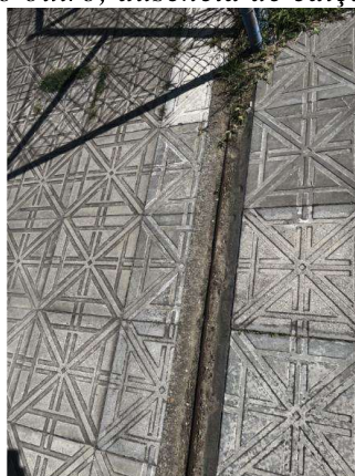
Figura 2. Rampa de acesso com piso trepidante e deteriorado, à esquerda e trilho do portão, à direita, o qual apresenta desnível e dificulta o deslocamento de pessoas em cadeira de rodas.
