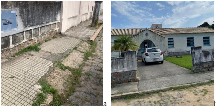
**Figura 1.** (a) Rampa de acesso à calçada com inclinação inadequada e sem sinalização tátil no piso. (b) Ausência de rebaixamento para acesso de veículos ou acesso irregular. Acervo pessoal da autora, 2023.
