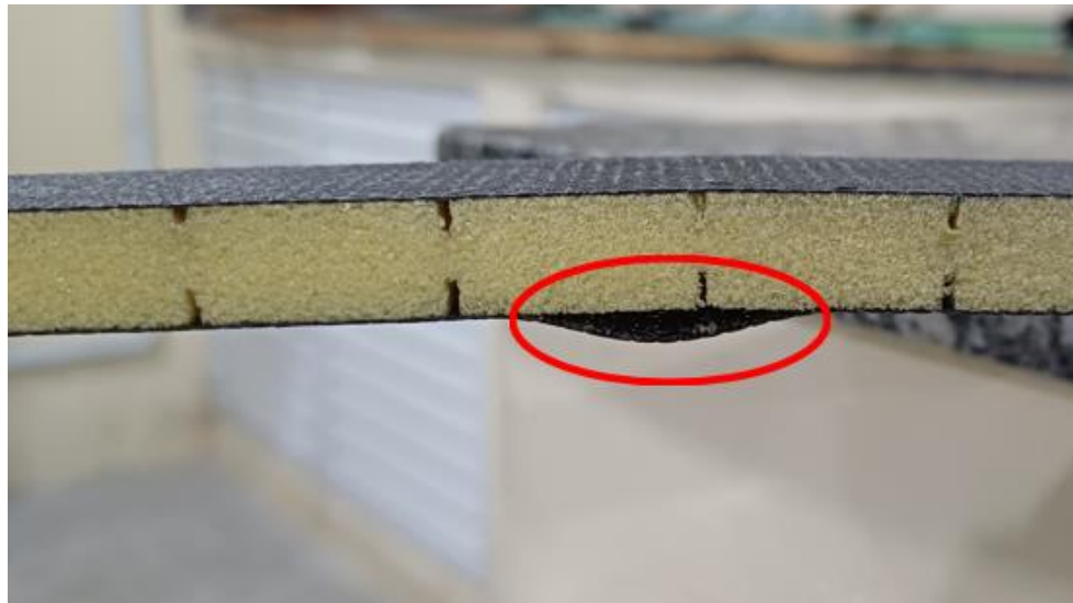
Figura 2. Detalhe da delaminação na fibra de carbono.
