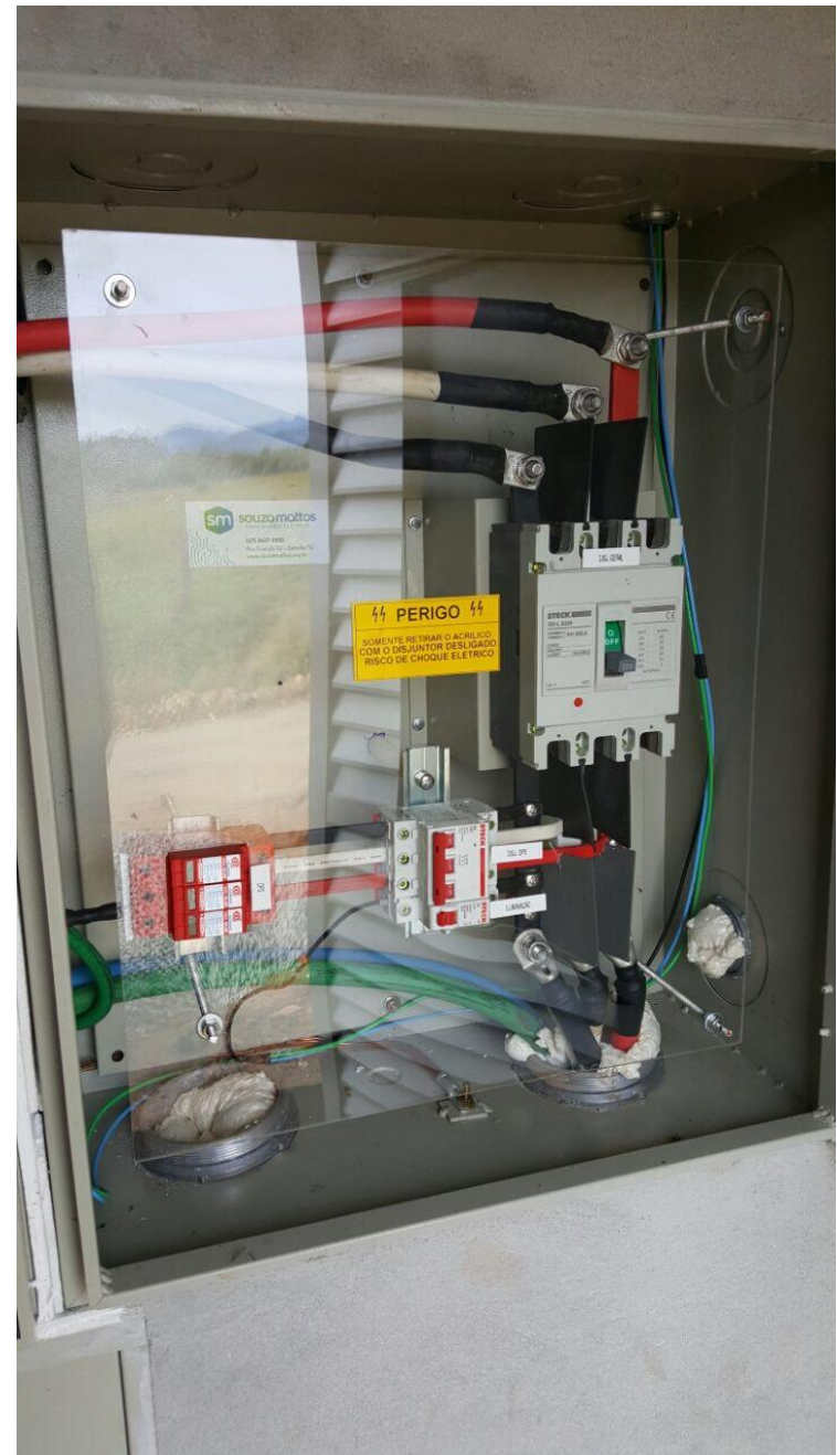
Proteção (Disjuntor e DPS)
