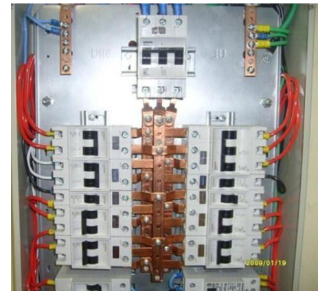
Esquema de ligação em quadro de distribuição (6.4.3.4.4)
