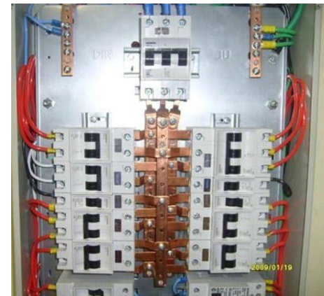
Esquema de ligação em quadro de distribuição (6.4.3.4.4)
